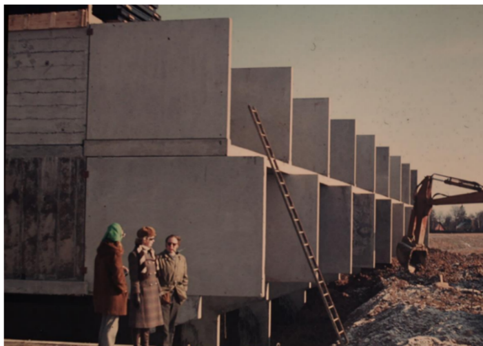
Figur 2 -Foto taget under opførelsen af rækkehusene
