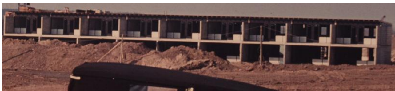
Figur 4 - Foto taget under opførelsen af rækkehusene
